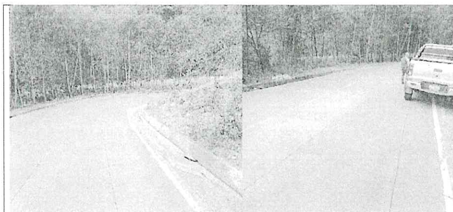
Renglones de trabajo ejecutados en la Estación 197+750, del tramo indicado; las actividades realizadas presentan condiciones aceptables. El sitio lo señalaron la empresa ejecutora y la empresa supervisora.
