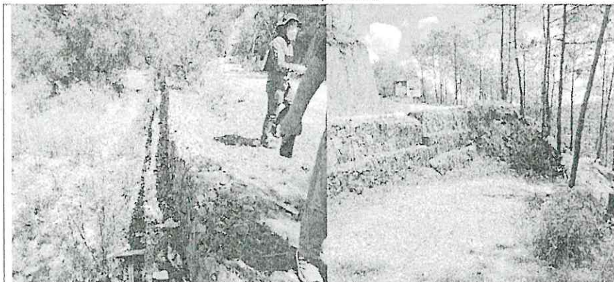
Construcción de muro de gaviones a lo largo del tramo carretero identificado, la estructura se encuentra en condiciones aceptables.
