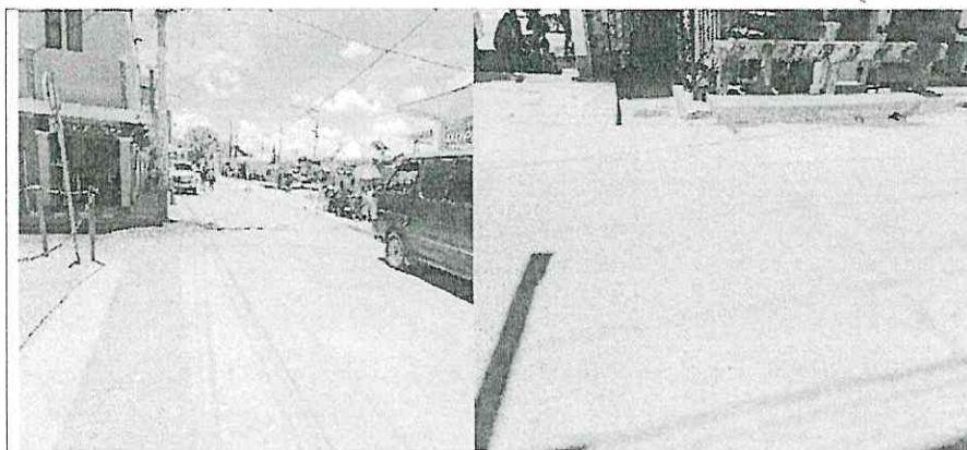
Trabajos realizados en la carpeta de rodadura de concreto hidráulico y cunetas de concreto laterales, los trabajos ejecutados se encuentran en condiciones aceptables.
